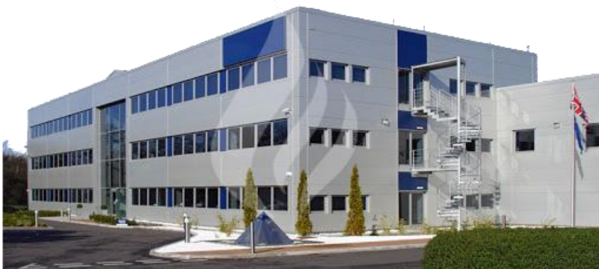
(ukážka budovy zo sendvičových panelov)
